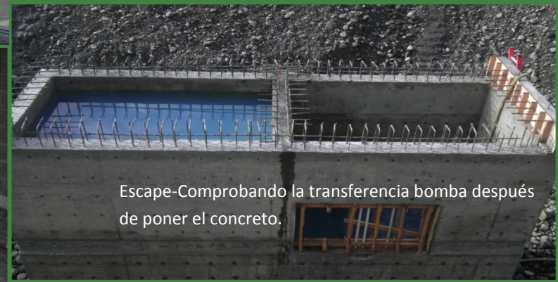
Formación encima de las paredes de edificio de transferencia bombas.
